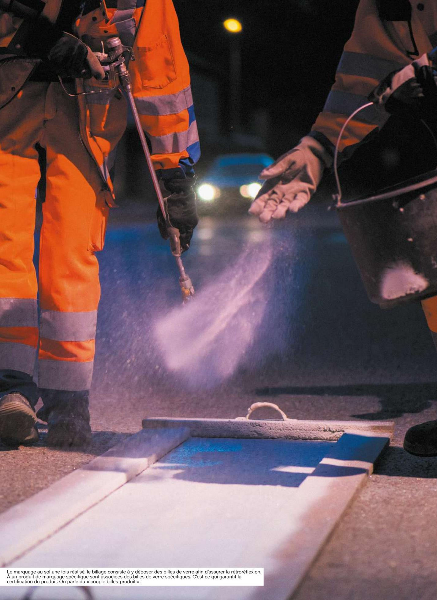
Le marquage au sol une fois réalisé, le billage consiste à y déposer des billes de verre afin d'assurer la rétro réflexion. A un produit de marquage spécifique sont associées des billes de verre spécifiques. C'est ce qui garantit la certification du produit. On parle du « couple billes-produit ».
